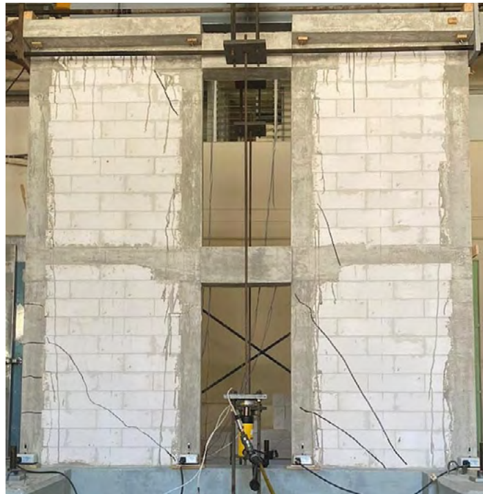
Figura 11. Muro acoplado de dos niveles donde se observan primeros agrietamientos diagonales
