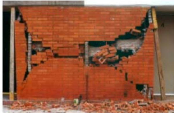
Figura 6 a) Falla por tensión diagonal; b) Falla por esfuerzos de corte (Alcocer et al., 1999)
