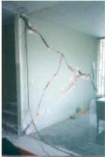
Figura 6 a) Falla por tensión diagonal; b) Falla por esfuerzos de corte (Alcocer et al., 1999)
