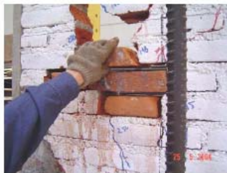
Figura 10 Relleno de grietas con pedacería de tabique (Flores et al., 2004)
