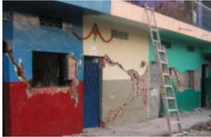
Figura 4 Daño que parte de las esquinas de las aberturas (Alcocer et al., 2003)
