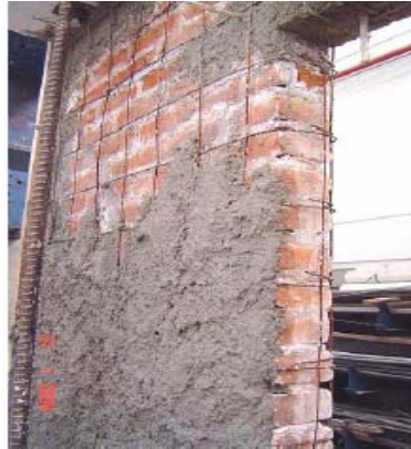
Figura 13 Uso de malla de alambre electrosoldada para fines de rehabilitación sísmica
