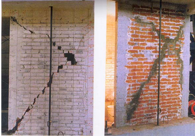
Figura 24 Muro de mampostería confinada antes y después de la preparación de la superficie para la colocación de malla electrosoldada (Ruiz, 1995)
