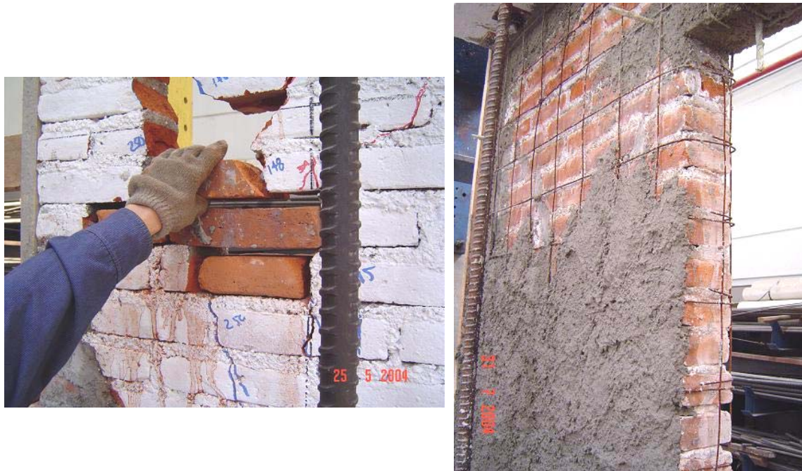
Figura 5 Proceso de reparación a) reemplazo de las piezas más dañadas, b) malla y recubrimiento con mortero
